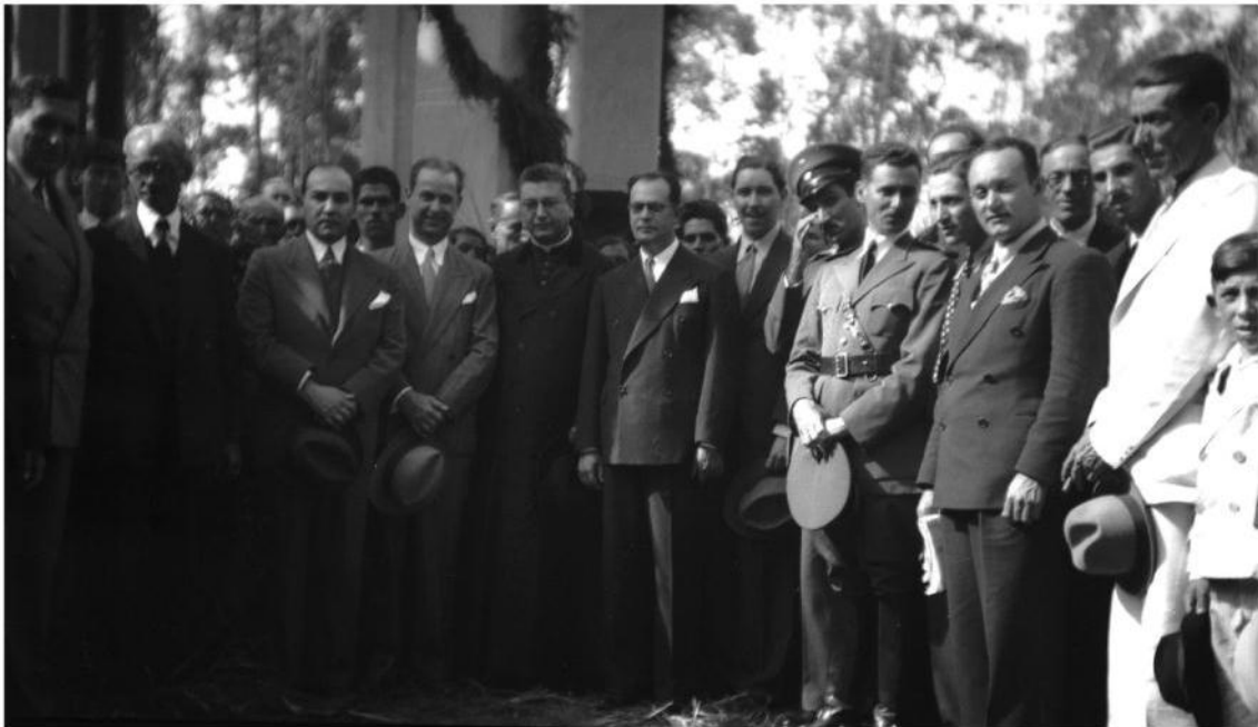
Fotos 1 e 2: Inauguração do sistema de abastecimento de água, dia 02 de fevereiro de 1937. Coleção Luis Guilherme Sampaio. Arquivo Público– Fundação Pró-Memória. de Indaiatuba
